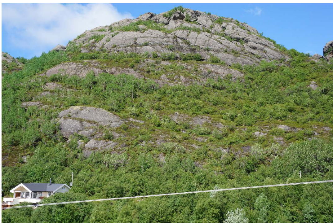
Figur 9 Område H2 ligger til høyre for hytta til venstre i bildet. Helt øverst mot toppen er det dårlig fjell (overheng).
